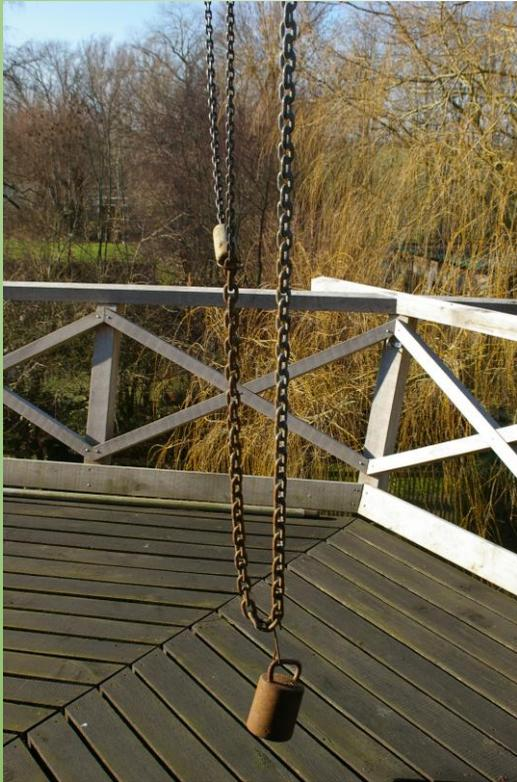
Durch Ziehen an jeweils einem Strang der Kette (5) wird der Jalousie-Balken (4) auf- oder abwärts bewegt. Dieser überträgt seine Hebelwirkung auf die in der Flügelachse liegende Zugstange (3), die wiederum die Spinne (2) im Zentrum bewegt. Über ein ansitzendes Gestänge werden die Klappen (1) geöffnet oder geschlossen. Folglich lässt sich so eine bestimmte Klappenöffnung und damit die gewünschte Drehgeschwindigkeit einstellen.
